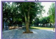
10 - Scherpe overgang tussen plein en park
